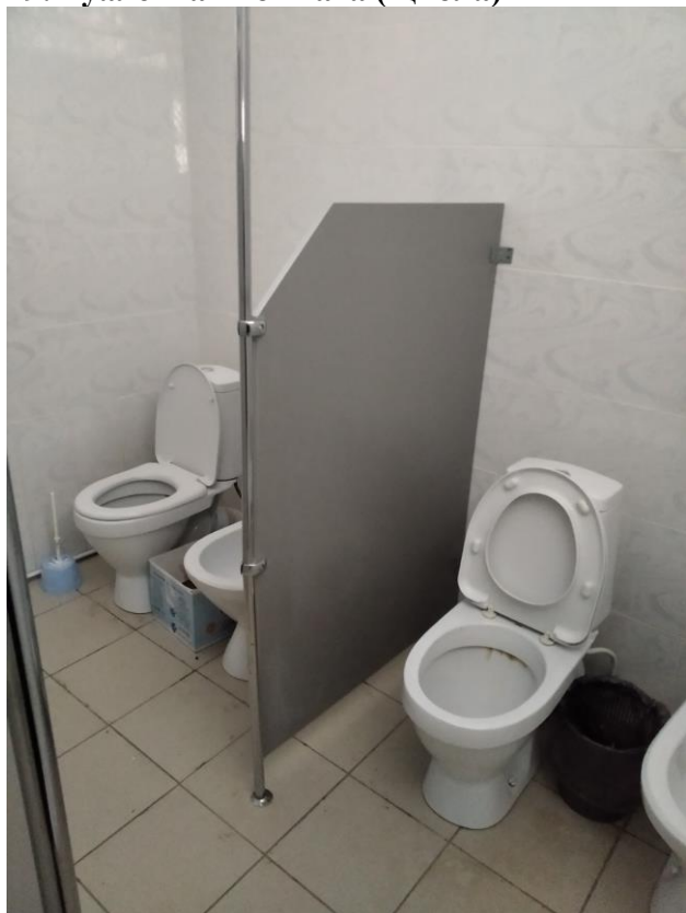
9. Туалетная комната (школа)
