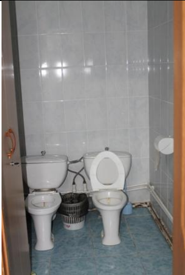
Фото № 37 Туалетная комната группа №1 (2 этаж)
