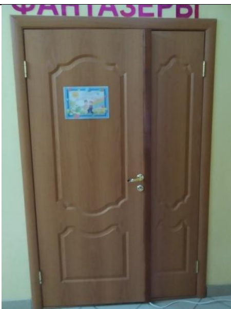
Фото № 25 Входная дверь в раздевалку (1 этаж)
