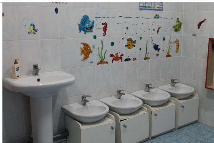
Фото № 40 Туалетная комната группа № 1( 2 этаж )
