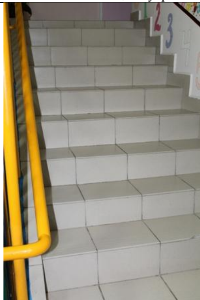
Фото № 19 Лестница внутренняя
