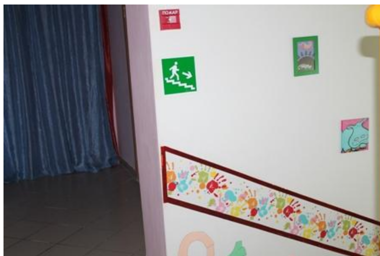
Фото № 63 Пути эвакуации (2 этаж)
