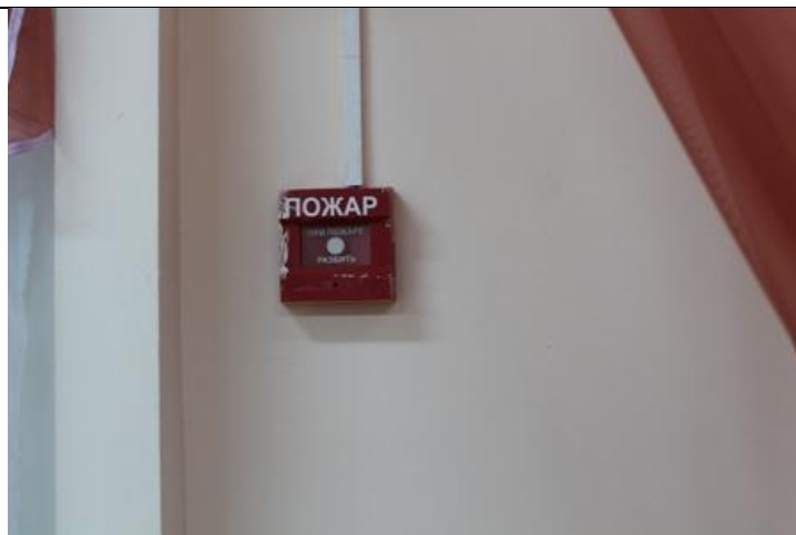
Фото № 61 Пути эвакуации
