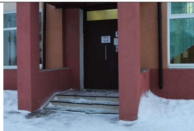
Фото № 9 Входная площадка №1
