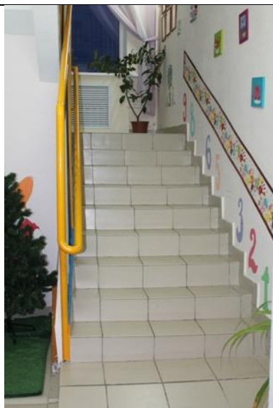
Фото № 17 Лестница внутренняя
