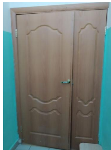
Фото № 22 Входная дверь (вход №1)
