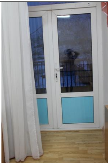
Фото № 59 Пути эвакуации (2 этаж)
