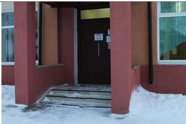
Фото № 21 Входные двери (вход № 1)
