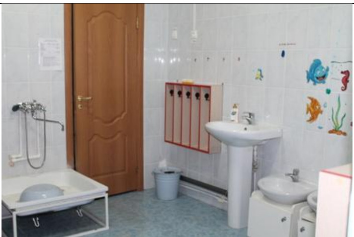
Фото № 39 Туалетная комната группа № 1(2 этаж)
