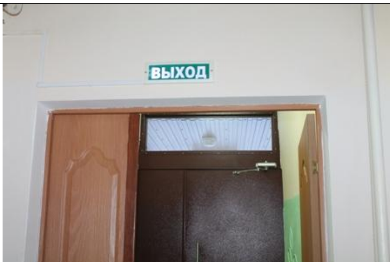
Фото № 69 Пути эвакуации 1 этаж
