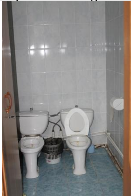
Фото № 42 Туалетная комната 2 этаж (для детей с ОВЗ)
