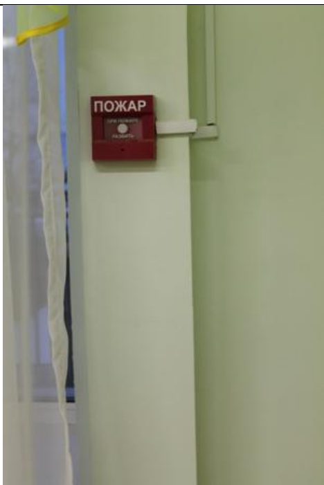
Фото № 65 Пути эвакуации
