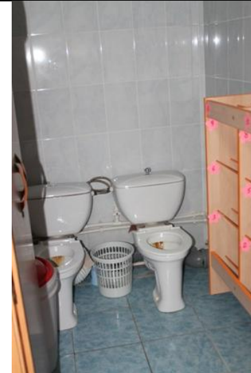
Фото № 38 Туалетная комната группа № 1 (2 этаж)
