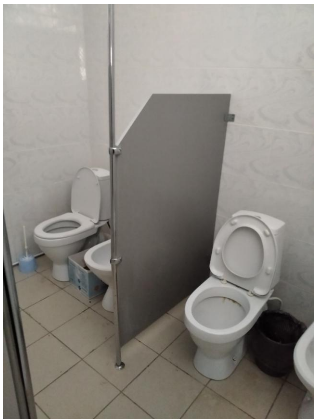
Фото № 5. Туалетная комната.
